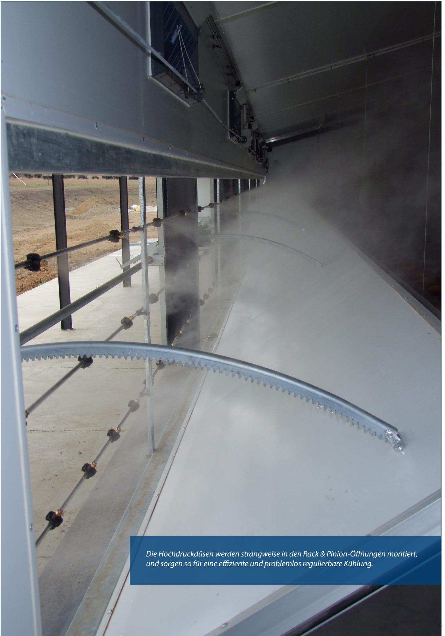
*Die Hochdruckdüsen werden strangweise in den Rack & Pinion-Öffnungen montiert, und sorgen so für eine effiziente und problemlos regulierbare Kühlung.*
